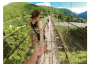
谷瀬の吊り橋
